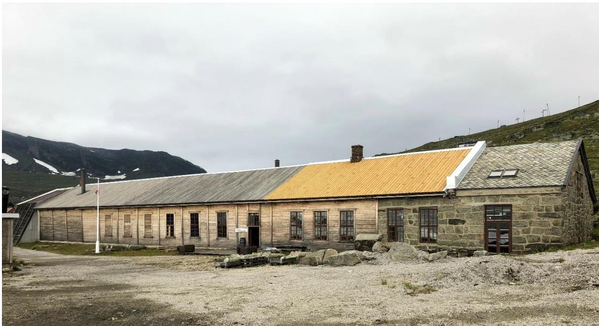
Hier das Bahnbaumuseum in ganzer Länge. Rechts der gemauerte Bereich. Er beherbergt die Werkstatt. Dort hat auch die Dachsanierung begonnen. Die erneuerte Holzverkleidung wird mit den vorher entfernten Schieferplatten eingedeckt, die vorübergehend auf zahlreichen Paletten auf ihre Wiederverwendung warten.
