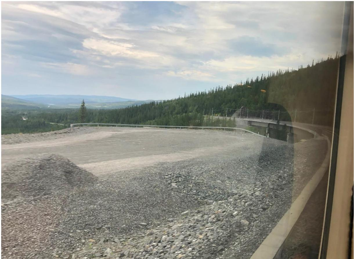
Vier Kilometer vor Storlien, direkt hinter der Grenze zu Schweden passiert der Zug eine neu gebaute Brücke. Das muss die Brücke sein, die einen Hang ersetzt, der abzurutschen drohte und weshalb die Bahn von 2013 bis 2015 unterbrochen war. Am Anfang der Brücke beginnt wie aus dem Nichts eine Oberleitung. Die Schweden haben also den Fahrdrabt der schon lange bis Storlien elektrifizierte Strecke bis zur Grenze verlängert und nun ist es an den Norwegern, ihre Hausaufgaben zu machen.
