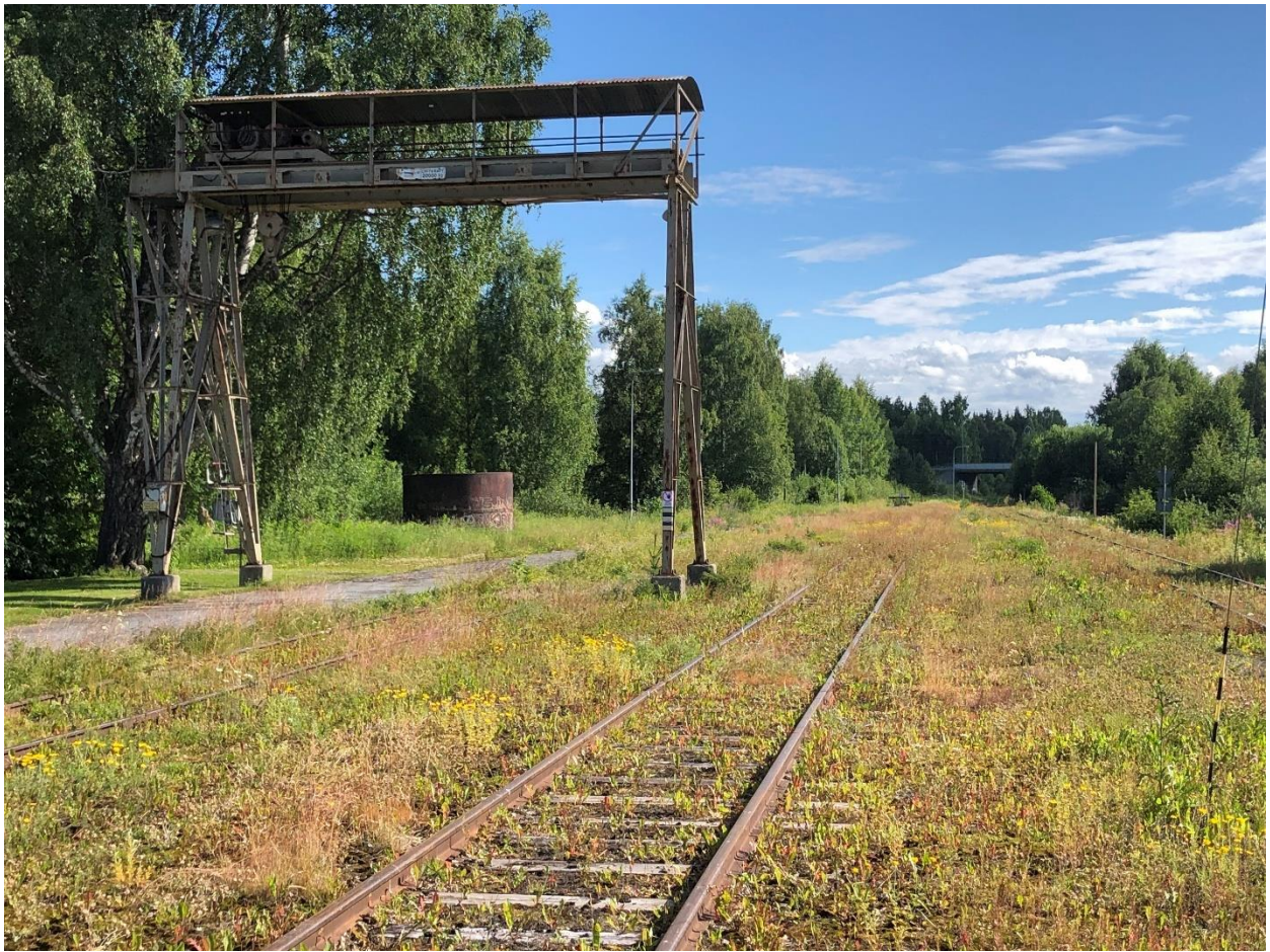
Im Bahnhof Lit fällt sofort dieser Portalkran auf und man fragt sich, was hier wohl auf Güterwagen verladen oder entladen wurde.
