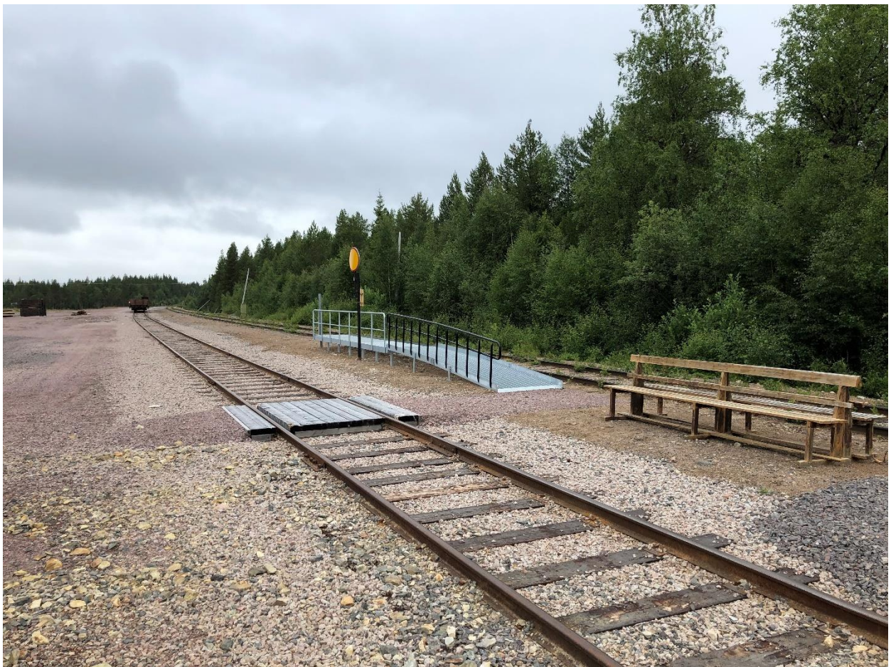
Der Bahnhof Slågnes wirkt abgeräumt aufgeräumt.
