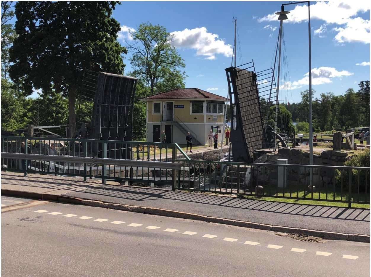
Der Schleusenwärter ist gleichzeitig auch Brückenwärter.
