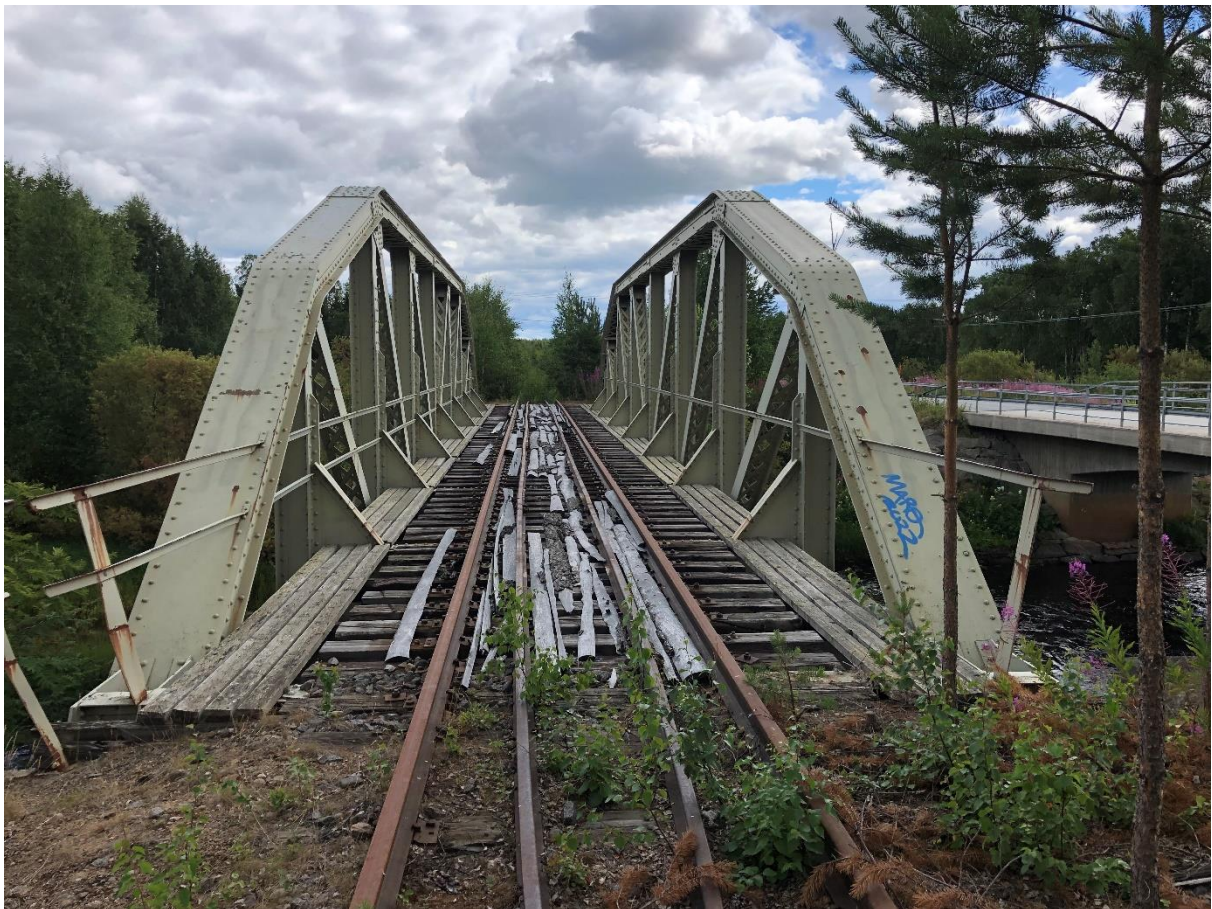
Auch die Brücke über den Sangisälven scheint für die Ewigkeit gebaut zu sein.
